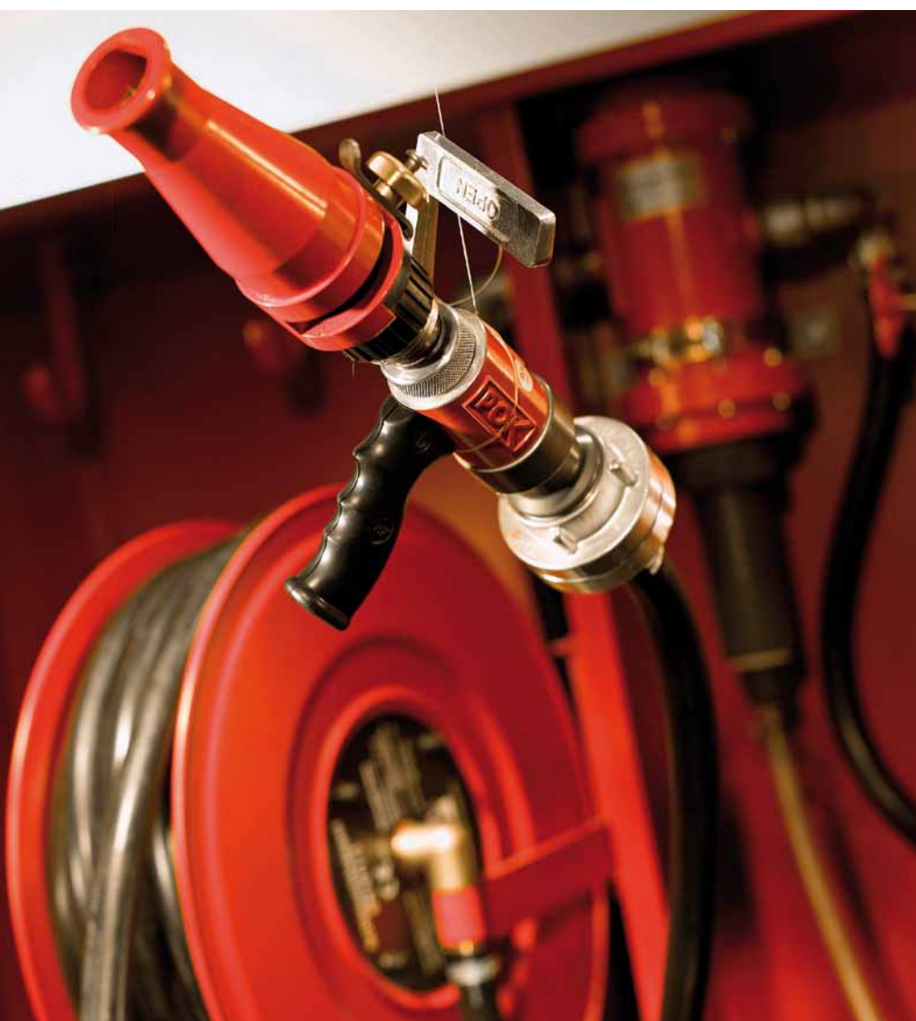
Die ordnungsgemäße Errichtung von Löschwasserleitungen und Wandhydranten ist nach den jeweiligen Ländervorschriften abnahmepflichtig.
